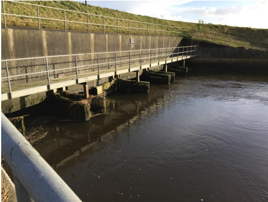
Figur 14: Kongeåslusens yderside (mod Vadehavet) og de sidehængslede ydre porte. Der er et sæt bestående af to sidehængslede porte til hvert af de 5 kamre. Derudover er der inde i slusen mulighed for at nedsænke stormskot (se figur af tegning af slusen).
