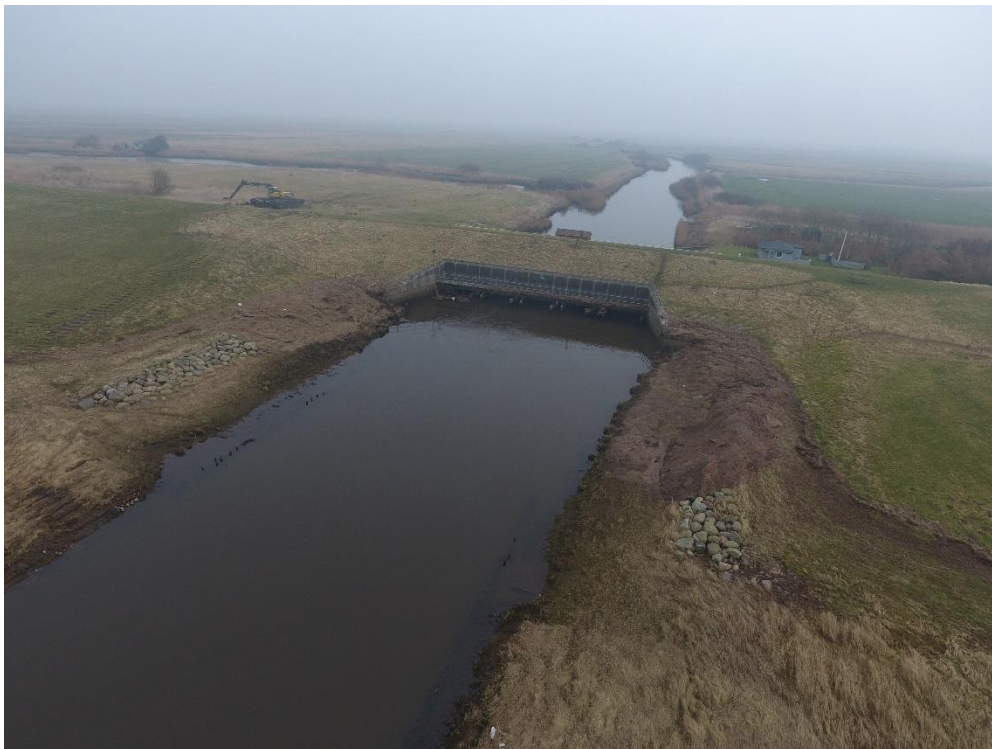
Figur 15: Kongeåslusens front mod Vadehavet og dele af kanalen gennem forlandet. Foto fra 19. februar 2018.
